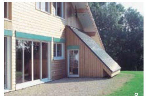
8. Chauffage solaire - Septfontaines
