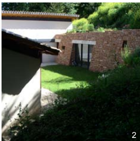
1. Maison à Villiers-en-Morvan - Arch. At. Correia 2. Agrandissement d'une maison individuelle à Charbonnières - Arch. Salvoldelli
