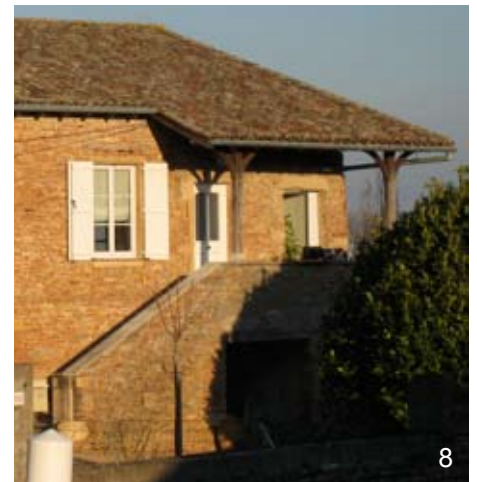
8. Forget, ou débord de toiture, à l'égoût du toit
