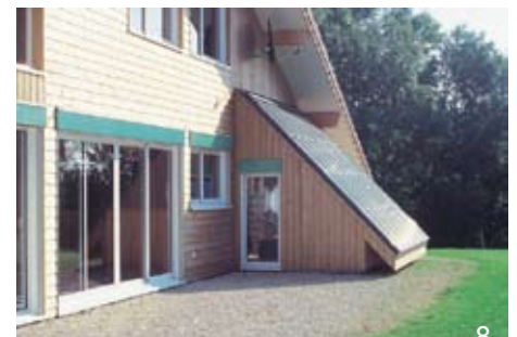
8. Chauffage solaire - Septfontaines
